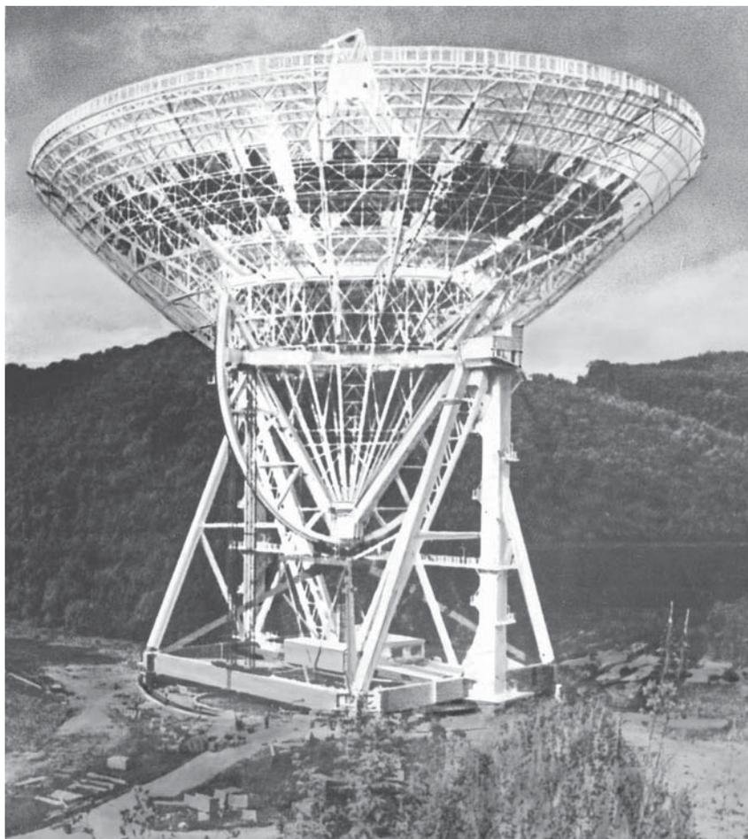
Рис. 4.4. Полноповоротный радиотелескоп в Эффельсберге (Германия, 1972 г.) диаметром 100 м. В конструкцию его параболического зеркала заложен гомологический принцип: при изменении наклона зеркало деформируется, но при этом сохраняет форму парабоида, хотя и с измененным фокусным расстоянием, которое корректируется соответствующим смещением облучателя. В результате зеркало эффективно фокусирует лучи длиной до 1,2 см, а центральная часть зеркала может строить радиоизображение на волнах до 7 мм
